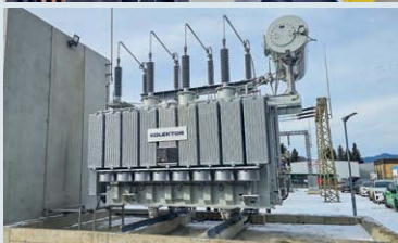
Der 90 Tonnen schwere Transformator steht fest an seinem Platz.
