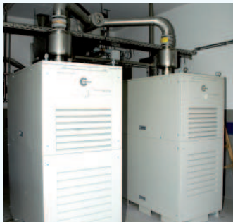
Foto: Stadtwerke Judenburg AG Gasturbinen erzeugen Strom und Wärme aus Biogas.
